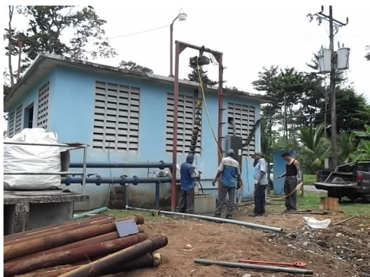
Labores de extracción de tubería y equipo de bombeo Pozo Sand Box n°1, previo al proceso de filmación.
