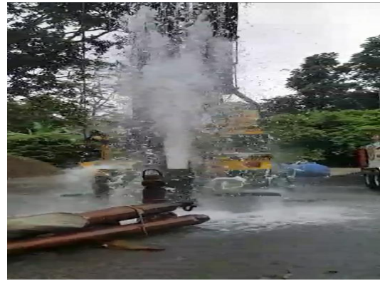
Labores de limpieza y desarrollo mediante la inyección de aire comprimido, presión utilizada 150 PSI.
