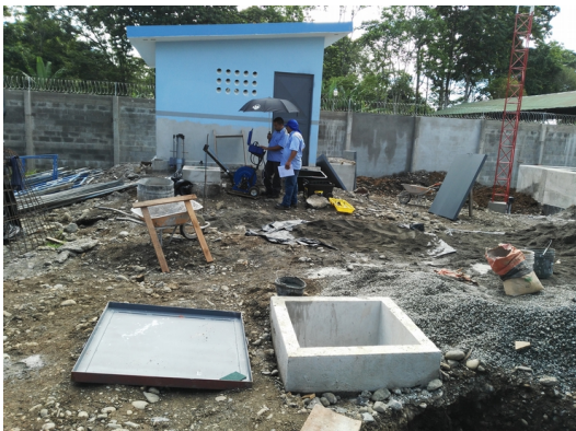
Estado del Pozo Sand Box, durante la filmación realizada el día 3
