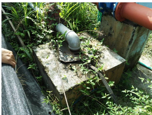
Estado del pozo Sand Box 1. Visita de inspección día 03-10-2018.
