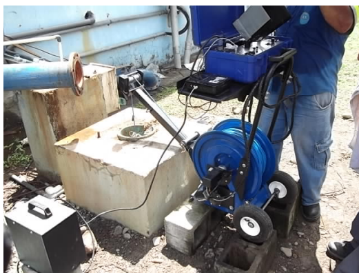
El día 8 de abril del 2015 la UTP realiza la filmación del pozo, previo al desarrollo del pistoneo.
